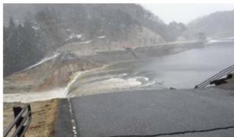
写真1 東北地方太平洋沖地震による決壊 (福島県)
